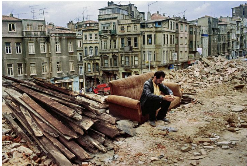
Şekil 3.9 Tarlabaşı Bulvarı yapım çalışmaları, 1980'ler, Fotoğraf: Ara Güler
