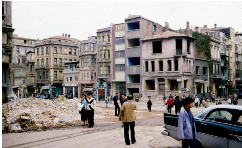
Şekil 3.8 Tarlabaşı Bulvarı yapım çalışmaları, Söylemezoğlu Arşivi, Salt Research, 1986
