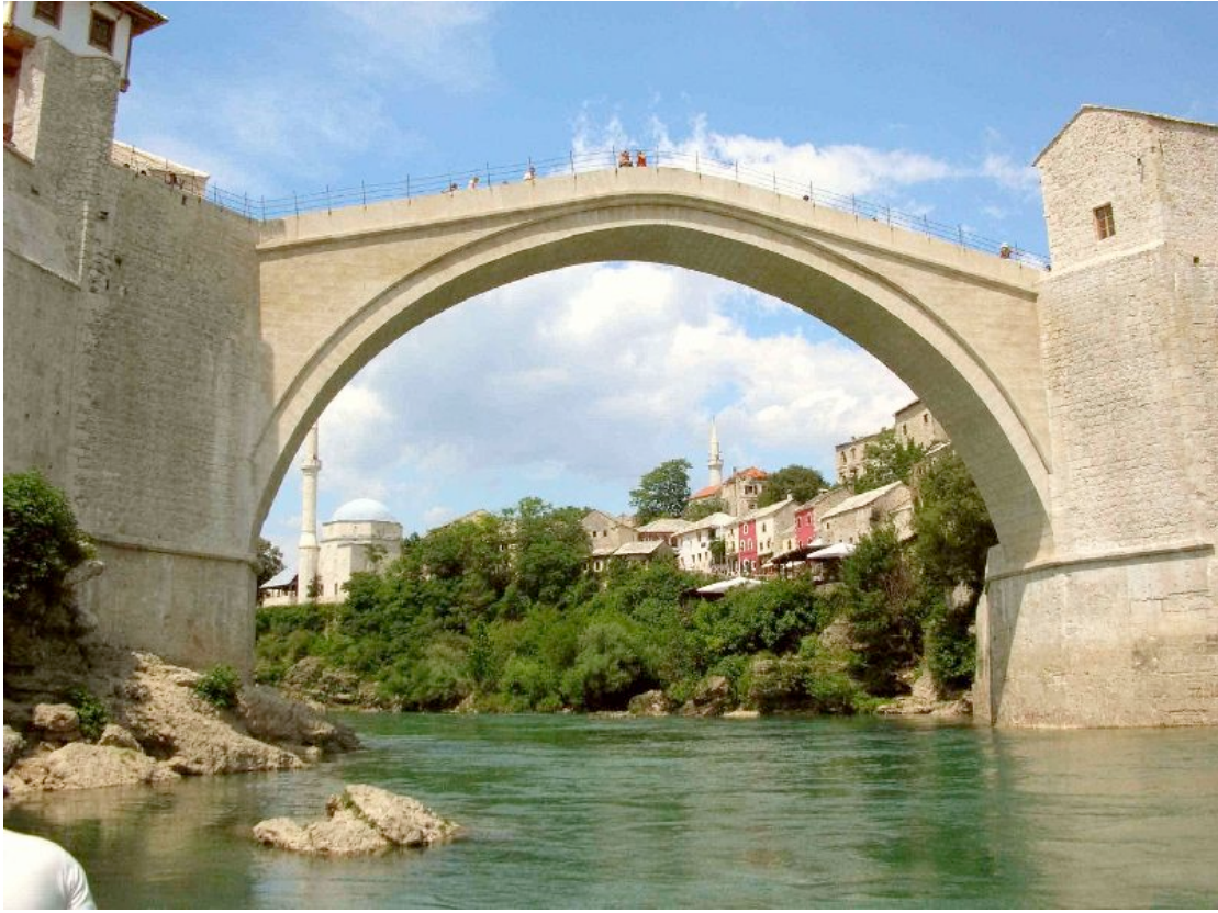
Şekil 6. Bosna-Hersek'in Mostar Şehrindeki Mostar Köprüsü
