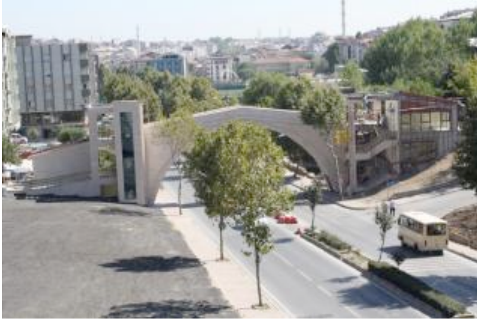
Şekil 7. Bayrampaşa İlçesi, Kocatepe Mahallesi’ndeki Mostar Köprüsü
