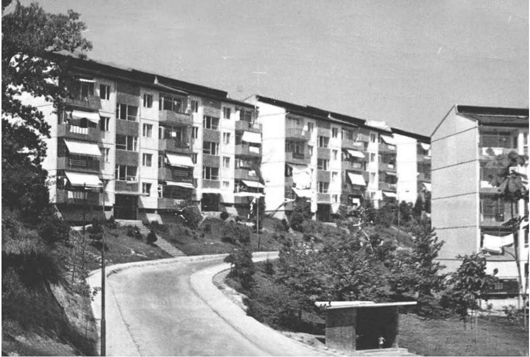
Şekil 4.10. Yıkılan Prefabrik 60 Evler.
