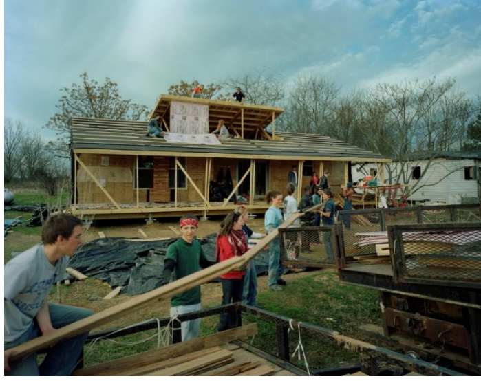
Şekil 5.1. Rural Studio öğrencileri düşük bütçeli konut projesi inşasında. Kaynak: Archdaily ( https://www.archdaily.com/898105/these-alabama-architecture-students-are-designing-and-building-low-cost-homes-for-rural-america?ad_medium=widget&ad_name=navigation-prev ), [Erişim: 01.04.2019]
