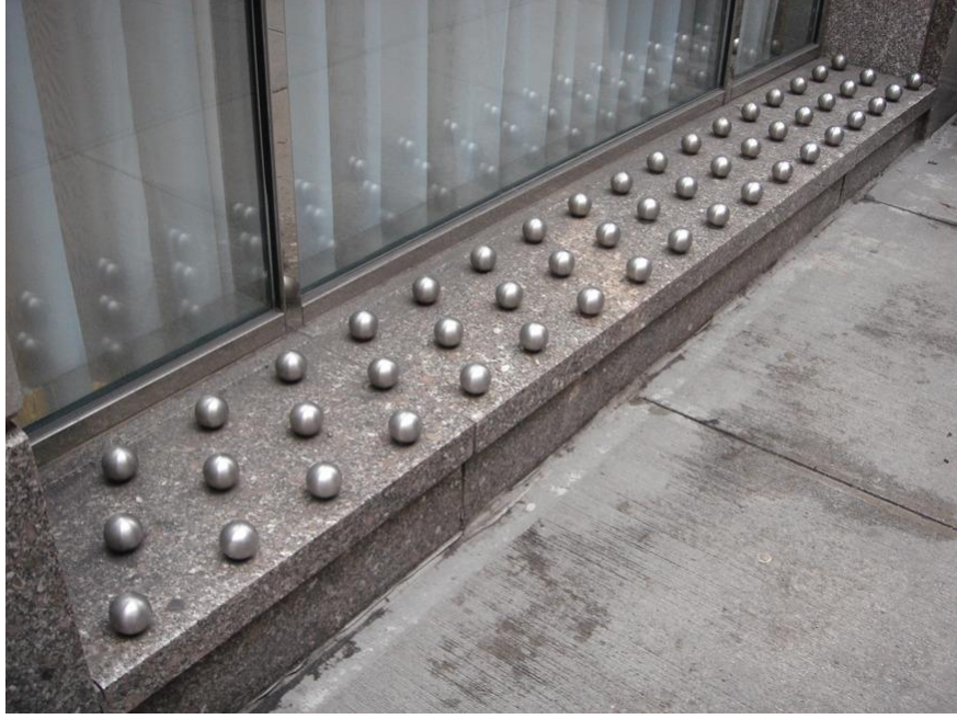
Şekil 5.6. San Francisco’da bir binaya ait denizliğin üzerine oturulmasını engellemeye yönelik yerleştirilmiş eklentiler. Kaynak: Dismalgarden, (URL 4), [Erişim tarihi: 20.01.2019]
