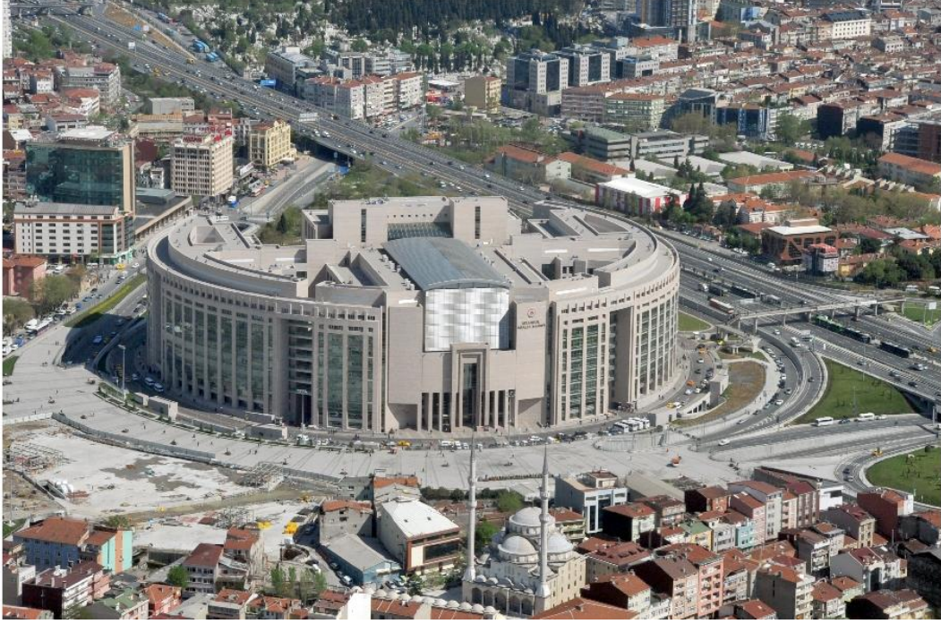
Şekil 4.2 164 İstanbul Çağlayan Adliyesi Bina Dış Görünümü
