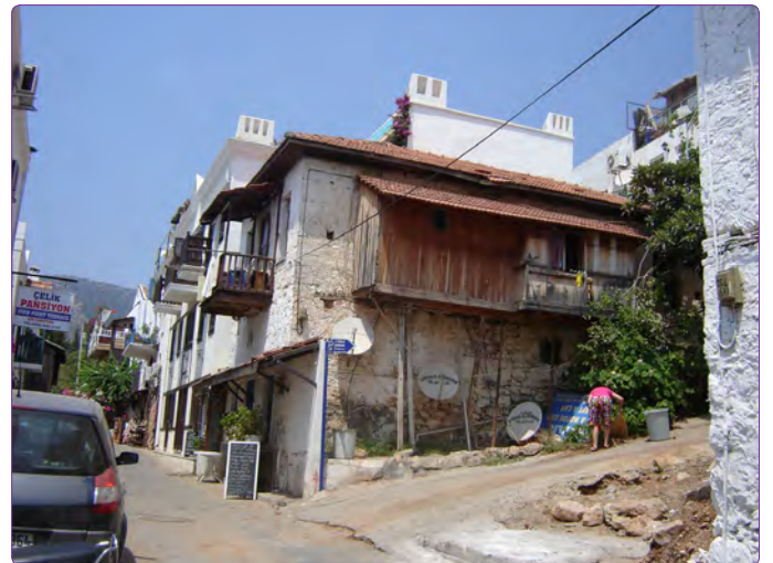
Şekil 25. Yan cephede hem üst kota giriş hem de servis işlevleriyle mekanlaşan yarı-açık çıkma.
