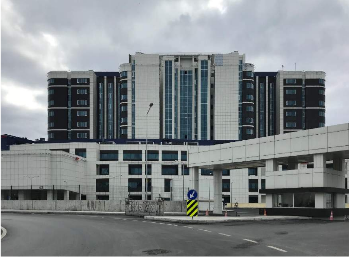
Şekil 51: Seyrantepe Devlet Hastanesi Binası (2020).
