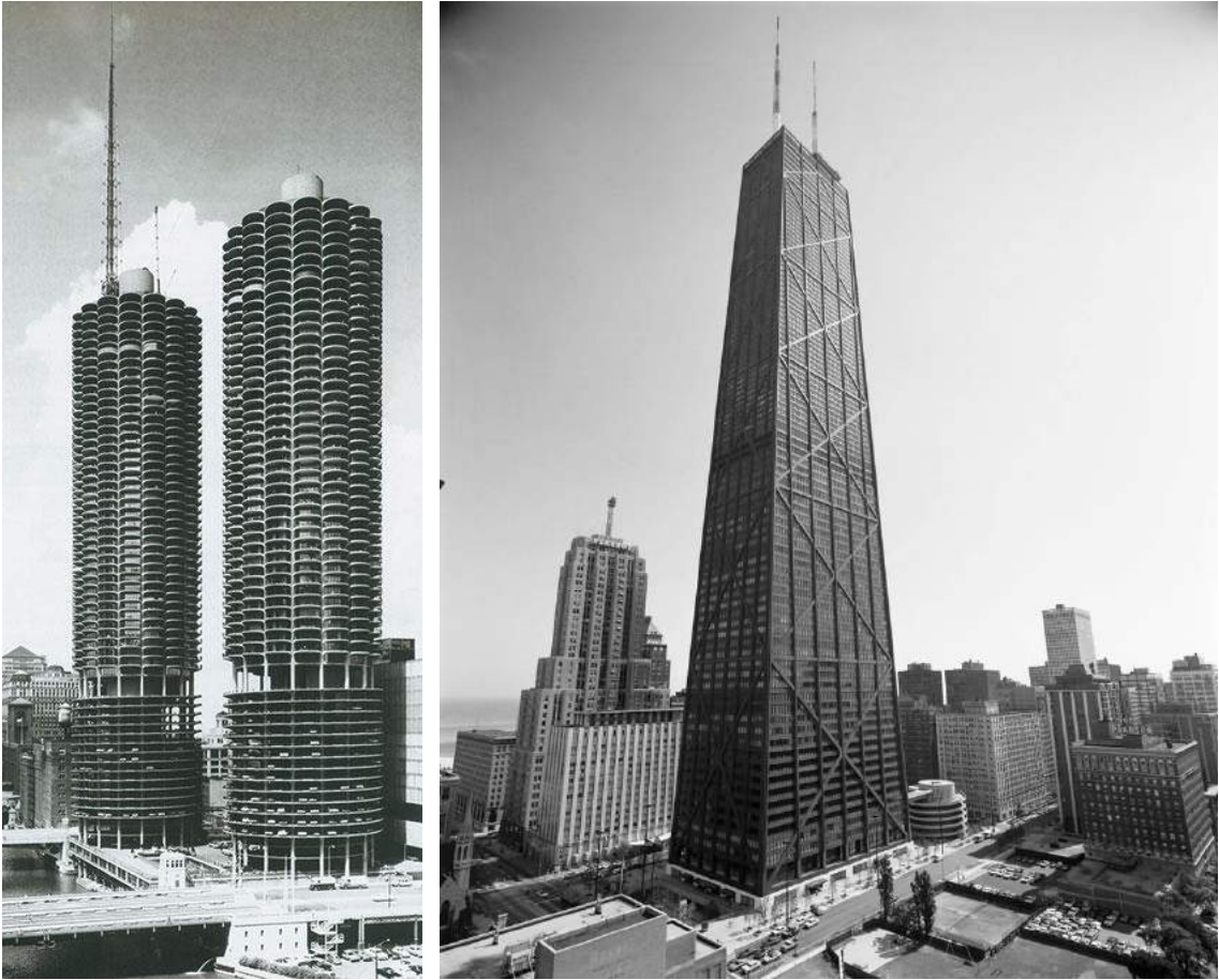
Şekil 57: Marina City (URL-23) ve John Hancock Merkezi Binası (URL-24).
