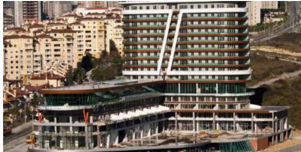
Şekil 73. Arkada eski Ispartakule (Toroslar), önde Bahçe City’s inşaatı
