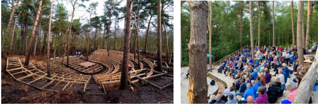
Şekil 7.11. Yapım aşaması, Aralık 2020 (solda). Sahnenin bitmiş hâli, Haziran 2021 (sağda). 65
