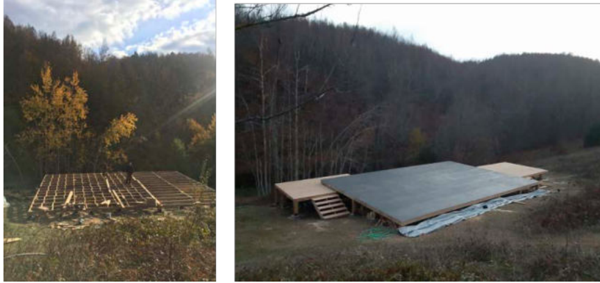
Şekil 7.4. ÇAK'ın inşa ettiği platform, Samanlı Dağı, 2020 (Kasım). 56
