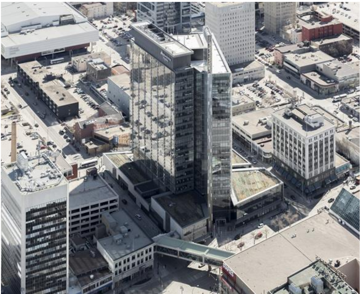
Fotoğraf 5.1.2.1. Manitoba Hydro Place, Kanada. KPMB Architects. (2009). Manitoba Hydro Place . [Fotoğraf].
